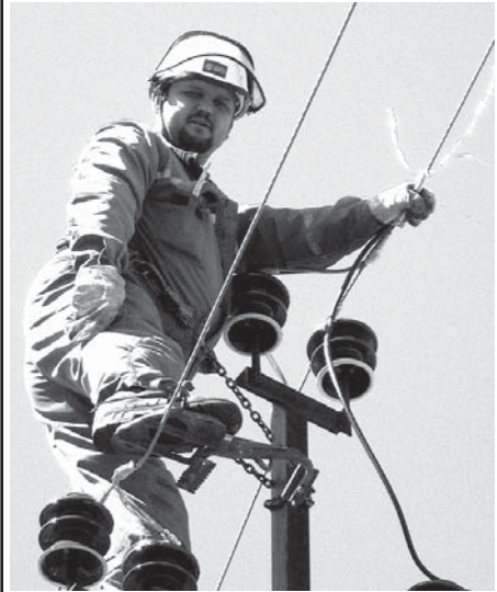
Электромонтер Н.Н. Тихий на подключении участка новой ЛЭП в п. Кардымово
