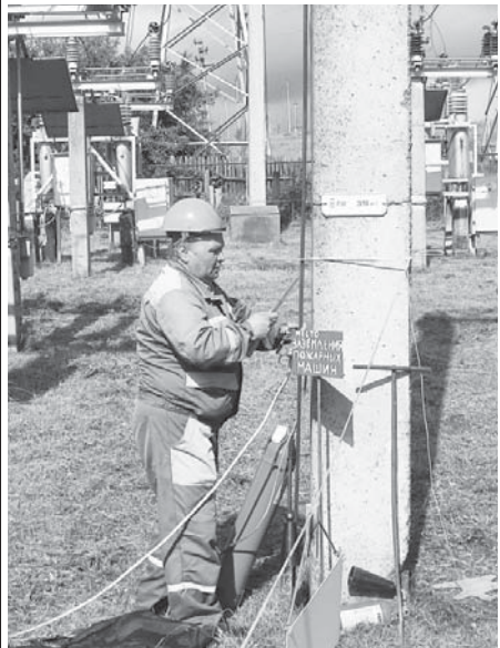
Электромонтер ОВБ Н.Н. Шулаков проводит допуск ремонтной бригады на ПС Кардымово
