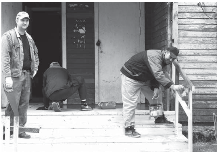
Новое крыльцо готово
