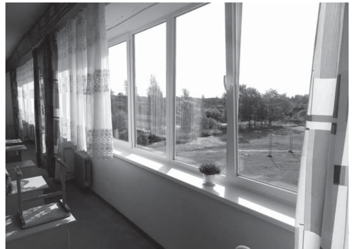
В кабинете биологии Кардымовской школы заменены оконные блоки и сделан косметический ремонт
