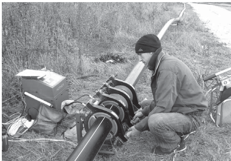
Работы по прокладке газопровода в д. Астрогань
