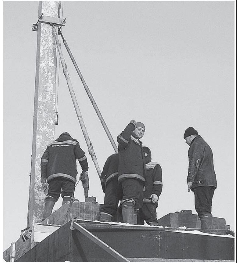
Фотоматериал с места строительства
