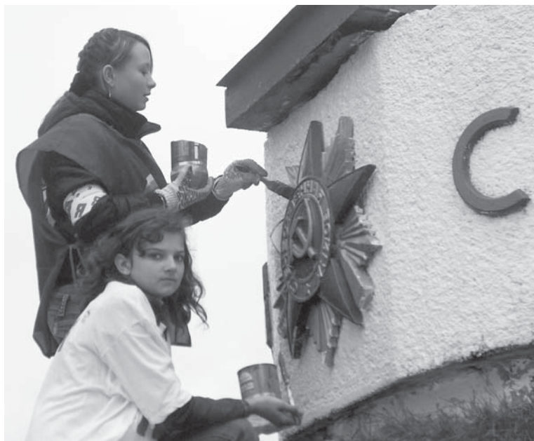
Ремонт памятника «Катюша» в д. Соловьево
